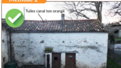
Photo de l'existant
